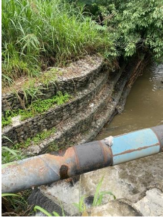
Paso de agua limpia, Puente El Portal. Autores: Sanchez y Velásquez (2023)
