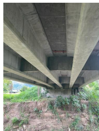
Vista de Tableros, Puente Valle de Oro Sur. Autores: Sanchez y Velásquez (2023)
