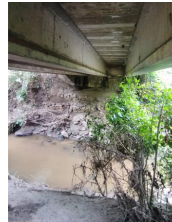
Vista de Tableros y Vigas, Puente Valle de Oro Norte. Autores: Sanchez y Velásquez (2023)
