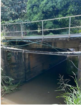
Cajón y paso peatonal, Puente Las Morochas. Autores: Sanchez y Velásquez (2023)
