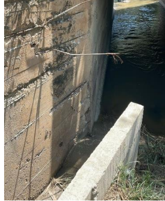
Cajón, Puente El Portal. Autores: Sanchez y Velásquez (2023)
