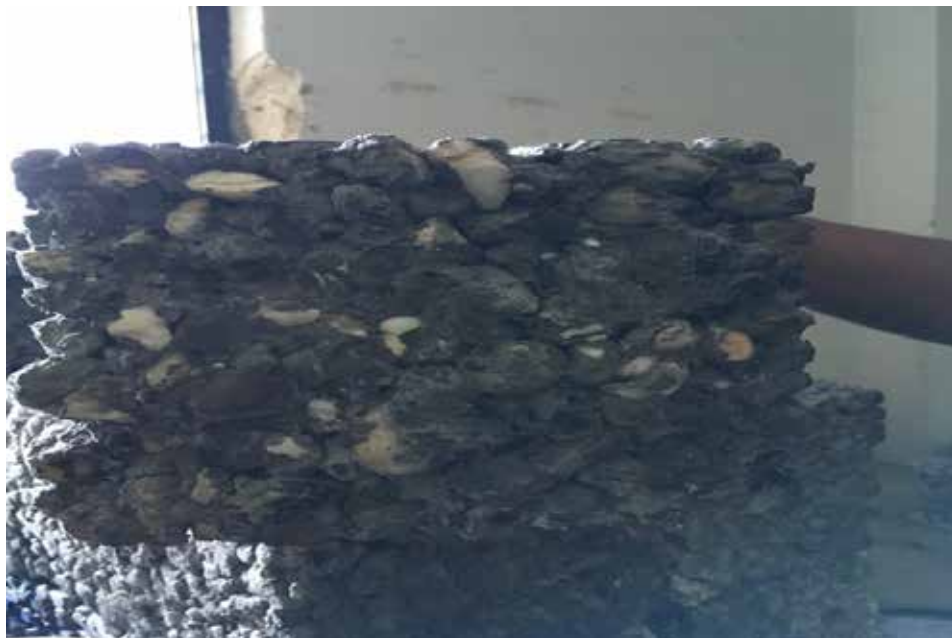
Figura 17. Vigüeta fracturada. Fuente: Izquierdo, Ruiz (2018).
