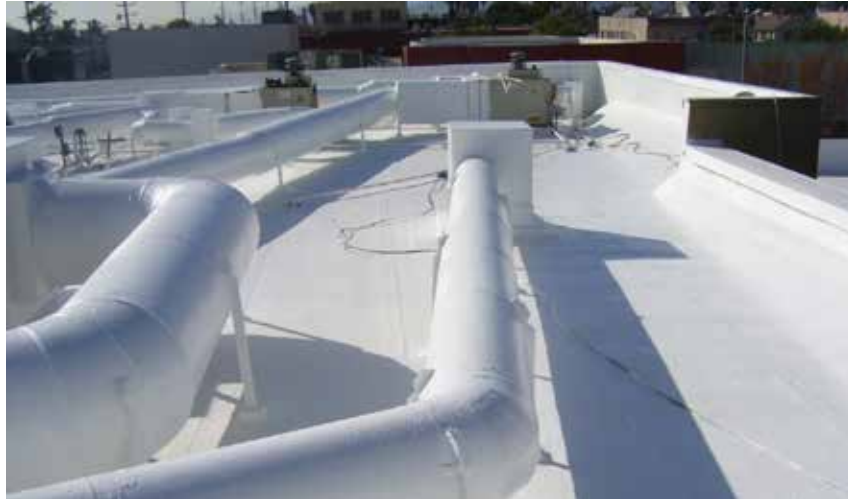
Figura 27. Techo recubierto con aislante Temp-Coat 101
