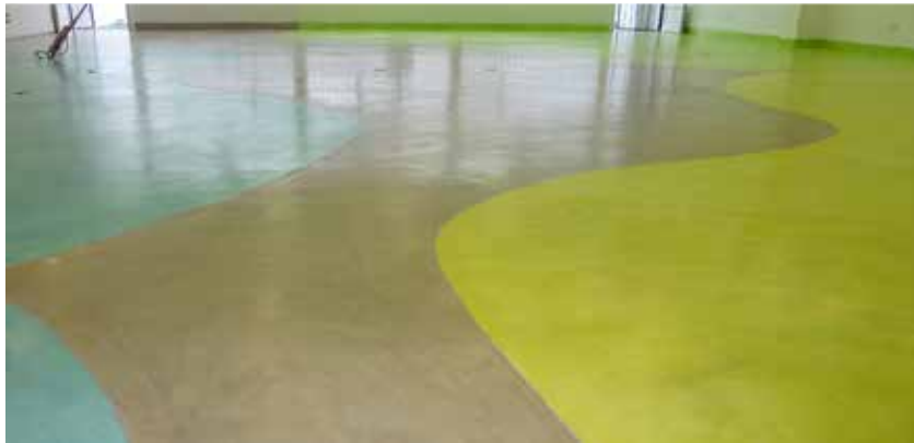
Acabados de pisos internos y externos de la edificación.
