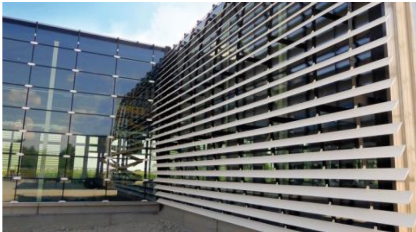
Figura 66. Celosía de acero inoxidable para la fachada. Fuente: La Autora (2023)
