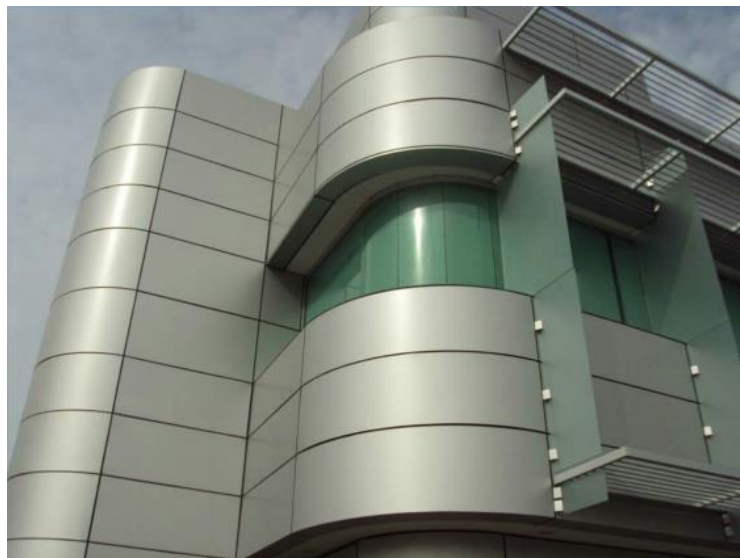
Figura 67. Paneles de aluminio para la fachada. Fuente: La Autora (2023)
