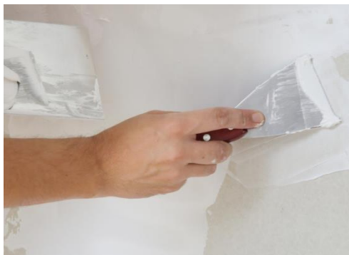
Figura 52. Paredes con revestimiento de friso liso de color según área. Fuente: La Autora (2023)
