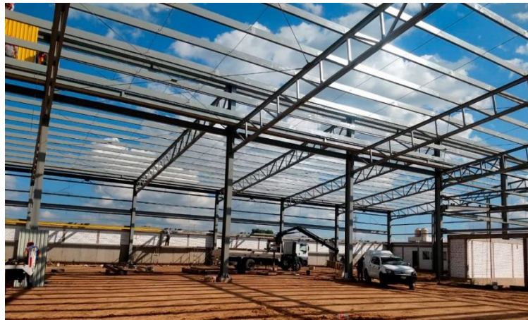
Figura 70. Estructura de acero. Fuente: La Autora (2023)
