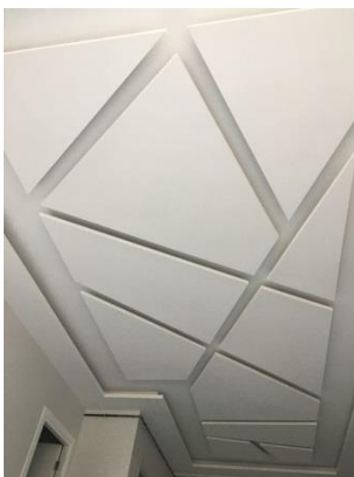
Figura 50. Revestimiento de techos interior, se utilizará el drywell. Fuente: La Autora (2023)
