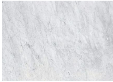
Figura 53. Paredes de los baños con revestimiento de mármol. Fuente: La Autora (2023)
