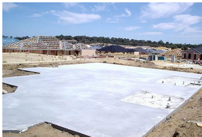
Figura 71. Losa de Fundación. Fuente: La Autora (2023)
