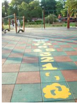
Figura 58. Baldosas encastrables para el piso del área al aire libre de la guardería. Fuente: La Autora (2023)
