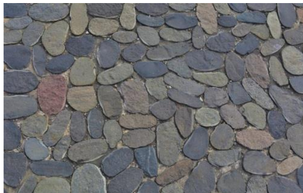
Figura 69. Piedra laja como piso de acabado para la Caminería. Fuente: La Autora (2023)
