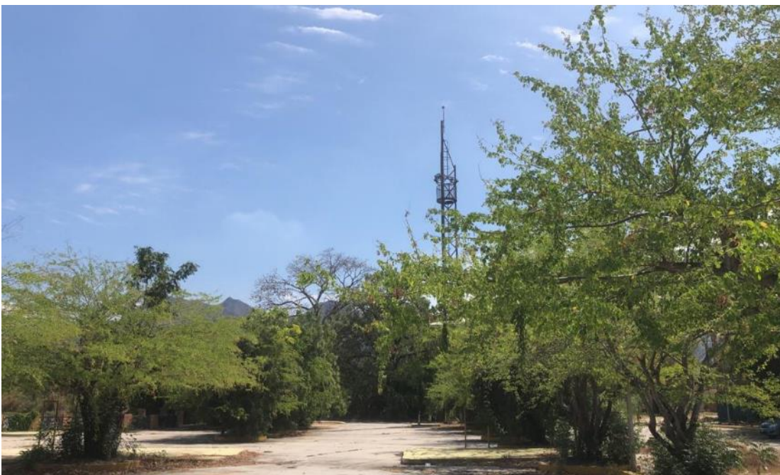
Imagen 3. Torre con tres luminarias
