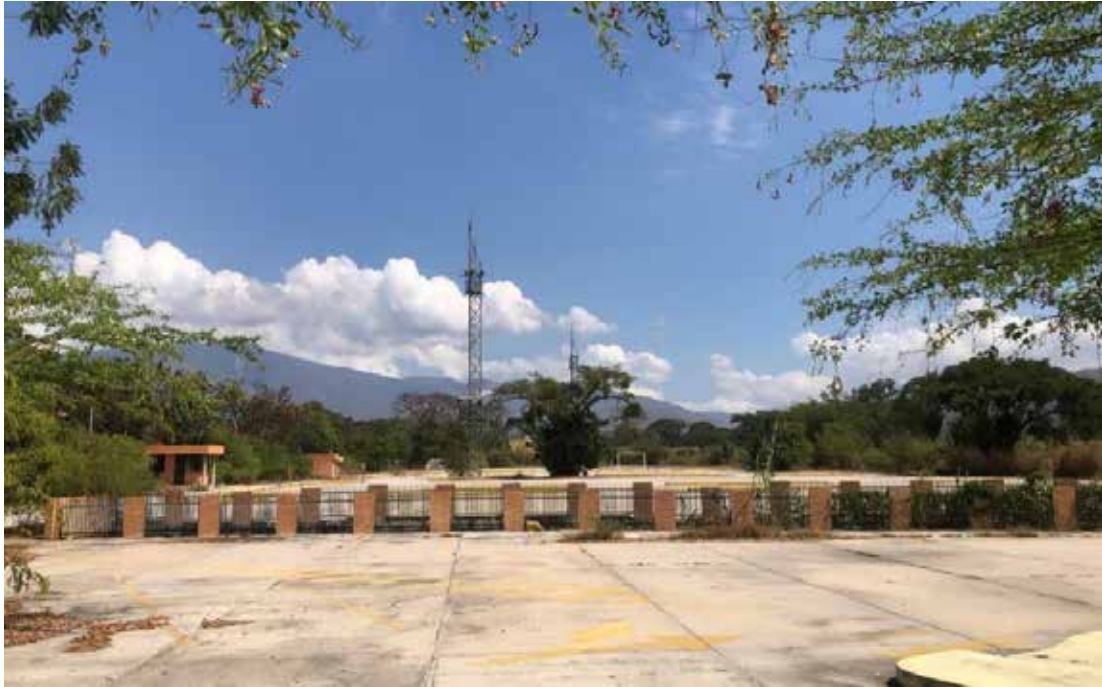
Imagen 4. Torre con tres (03) luminarias
