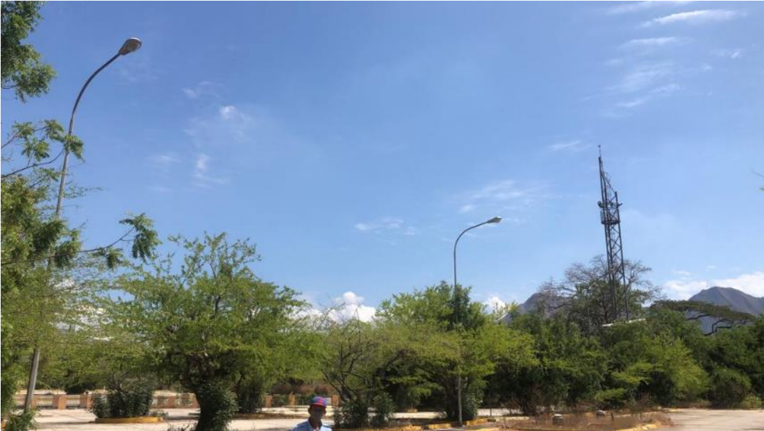
Imagen 2. Postes con luminarias sencillas y torre con tres (3) luminarias
