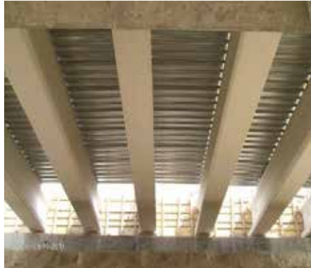
Figura 46. Losa acero a la vista (2018)
