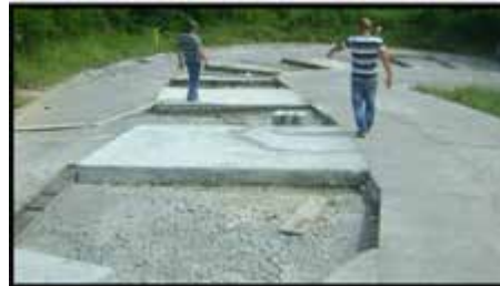
Figura 14: Losa de concreto vial
