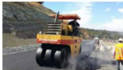
Figura 23: compactador de rodillo neumático.
