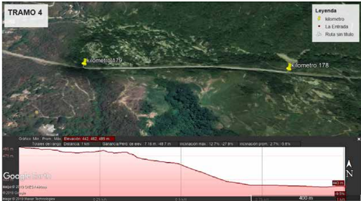
Cuadro 10 Análisis de inspección Tramo 4 Valencia –Puerto Cabello
