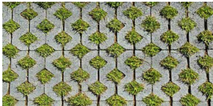
Figura 27. Acabados de pisos externos – Adoquín Calado.
