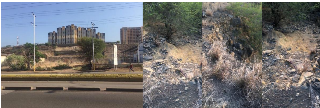
Figura 3. Evidencia fotográfica del deslave progresivo del Cerro Sur.
