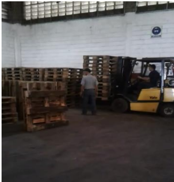
Figura 33. Demarcación de señalizaciones en suelo del galpón desgastadas.
