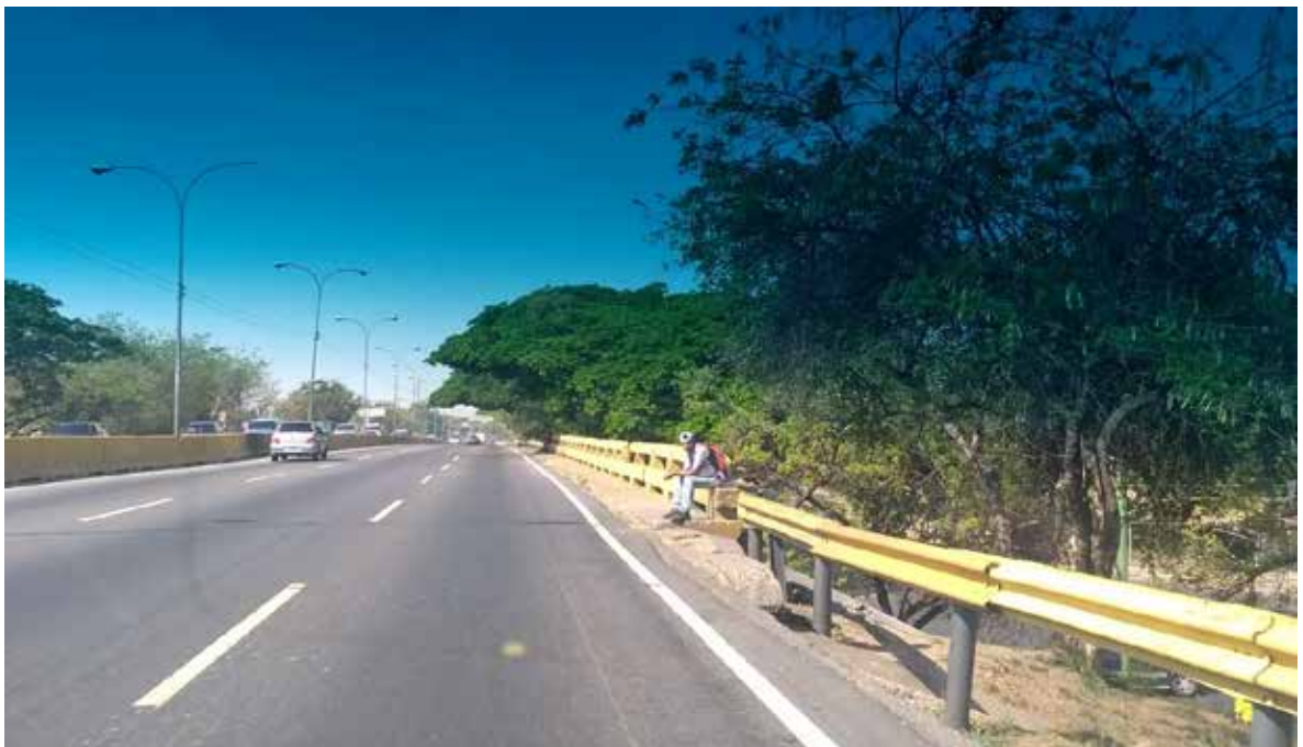
Figura 11. Parada del Puente de Los Samanes. Fuente: Irigoyen, R; Ryczko, S (2018)
