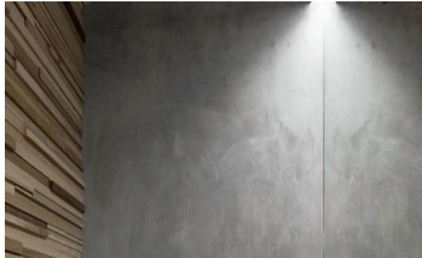
Figura 19. Fachada con revestimiento de microcemento. Fuente: Google images (2022)
