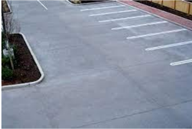
Figura 23. Piso concreto armado. Fuente: Google grupo ISOTEX (2022)
