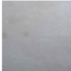
Figura 19. Freites, A. Revestimiento de pisos en áreas áreas sanitarias. (2023)
