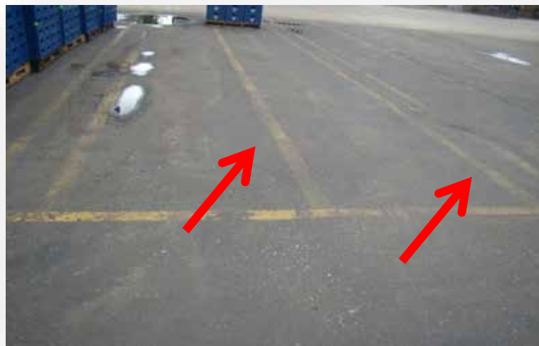
Figura 5,6. Situación actual del almacén de producto terminado de Cervecería Polar Planta Metalgráfica.
