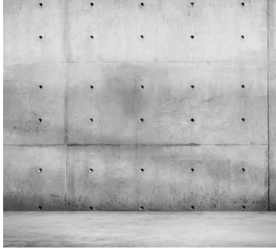
Figura20. Concreto en obra limpia
