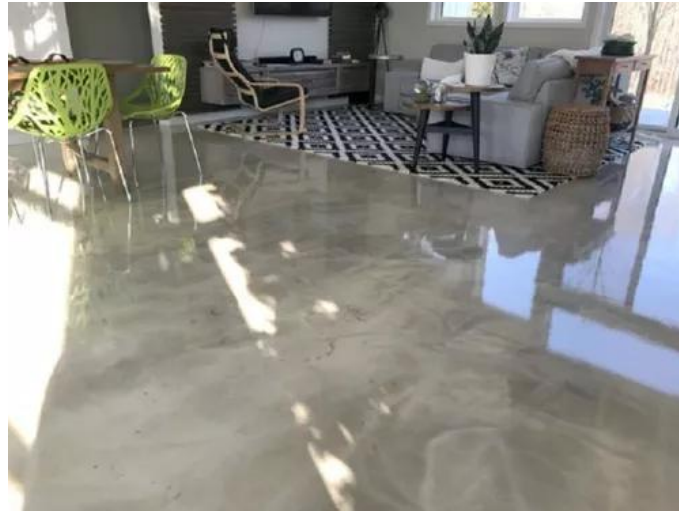
Figura 26. Acabado de piso en resina epoxica
