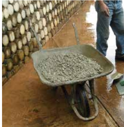
Figura 7: Mezcla de Concreto
