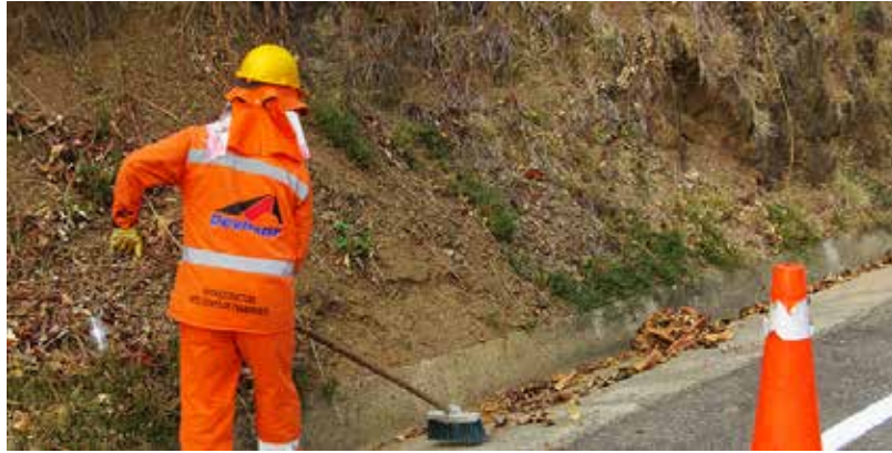
Figura 47: Mantenimiento de elementos hidráulicos.
