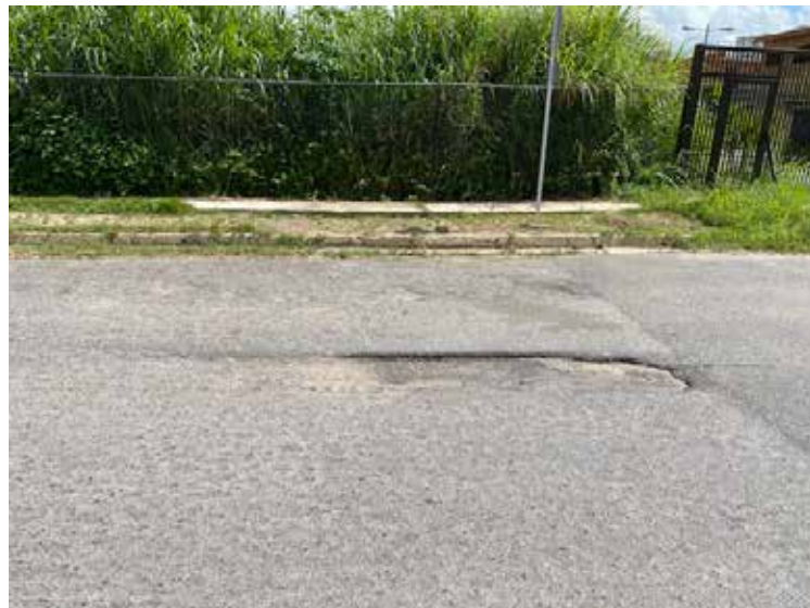
Figura 65: Hundimiento.
