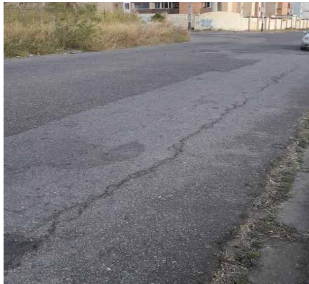
Figura 71: Grieta longitudinal.
