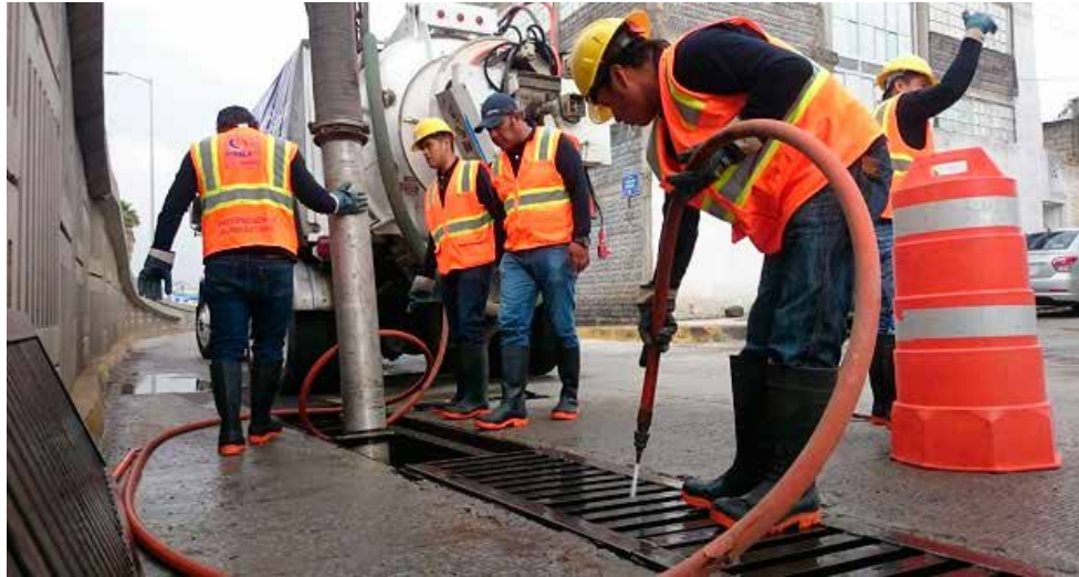
Figura 101: Mantenimiento de elementos hidráulicos.
