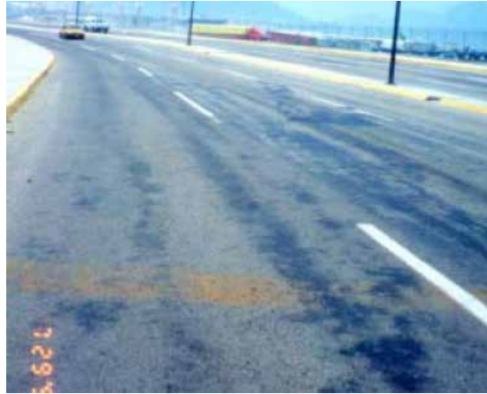
Figura 23: Ejemplo de exudación.
