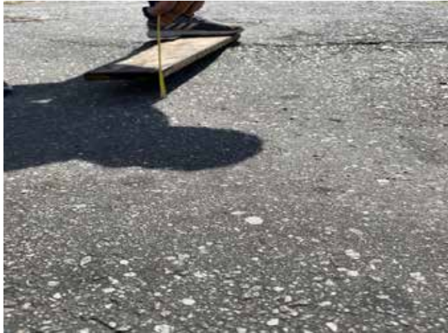
Figura 60: Hundimiento.
