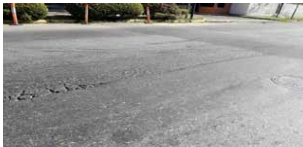
Figura 55: Grieta longitudinal.
