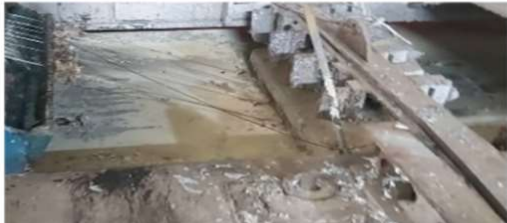
Figura N°18. ILUSTRACIÓN DEL PASE DE ALAMBRE POR EL CONJUNTO DE SEPARADORES DE LA FONTANA, EN TREXA C.A
