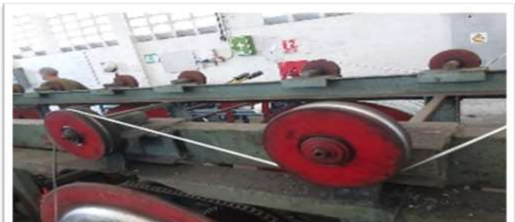
Figura N°20. ILUSTRACIÓN DE LAS POLEAS DE RODAMIENTO DEL ALAMBRE GALVANIZADO, EN TREXA C.A
