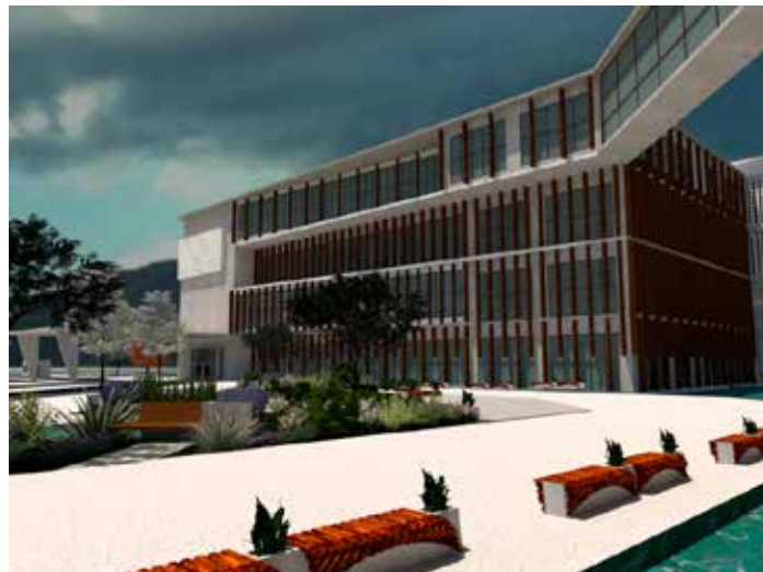
Figura 17: Parasoles de fachadas. Fuente: Principal (2020).
