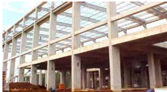
Figura 70: Estructura de hormigón armado. fuente: http://www.arqhys.com/construcciones/estructuras-hormigon-armado.html (2017).
