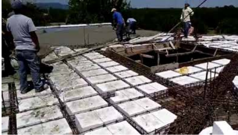
Figura 72: losa de entre piso nervada. Fuente: http://mrebot.com/Como_construir_una_losa-Colado_de_losa_aligerada_con_revolvedora/n2IN55KKbDw.video . (2017).
