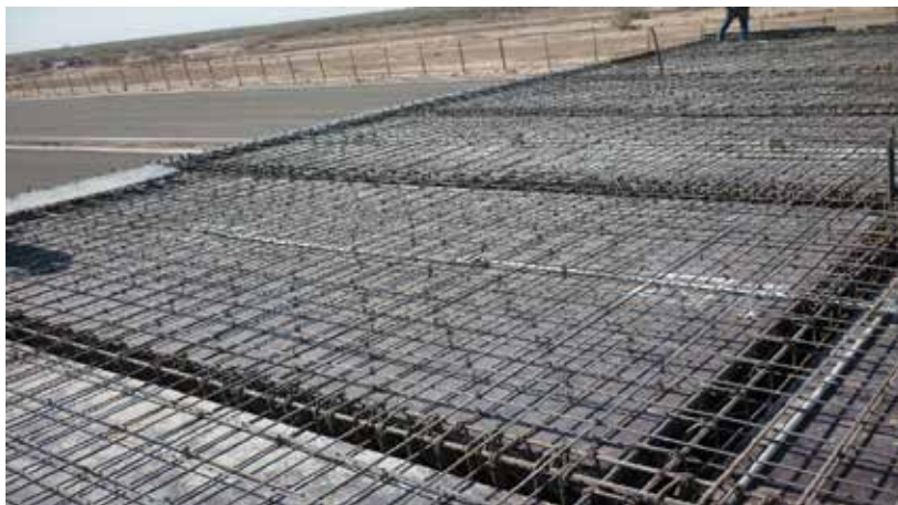
Figura 71: losa maciza. Fuente: https://fotos.habitissimo.com.mx/foto/armado-acero-losa_132158 (2017).
