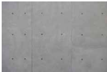
Figura 47: Concreto armado. Fuente: https://es.dreamstime.com/imagenes-de-archivo-concreto-image10146264 .(2017).
