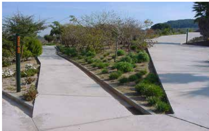
Figura 56: Acabado de piso de concreto en sitio. Fuente: https://fractalesyarquitectura.wordpress.com/2013/04/18/e-l-jardin-botanico-de-barcelona/dsc03141/ (2017).
