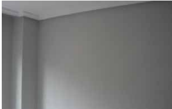
Figura 51: Acabado de pintura vinílica. Fuente: https://www.decorablog.com/pintar-una-pared-estropeada/ .(2017).
