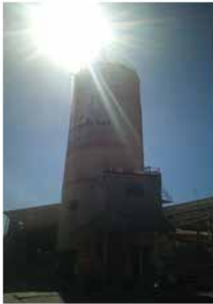
Anexo 5. Silo A
