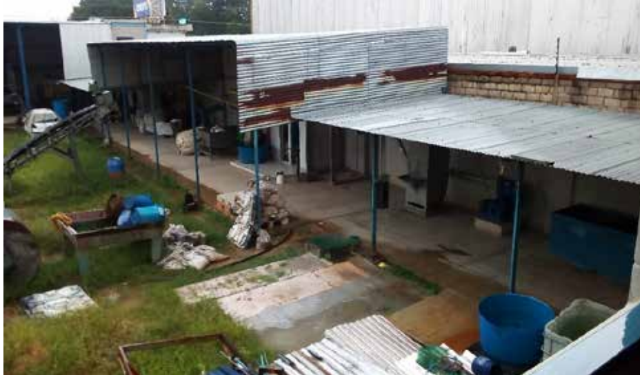
Figura 7. vista aérea de la planta actual.
