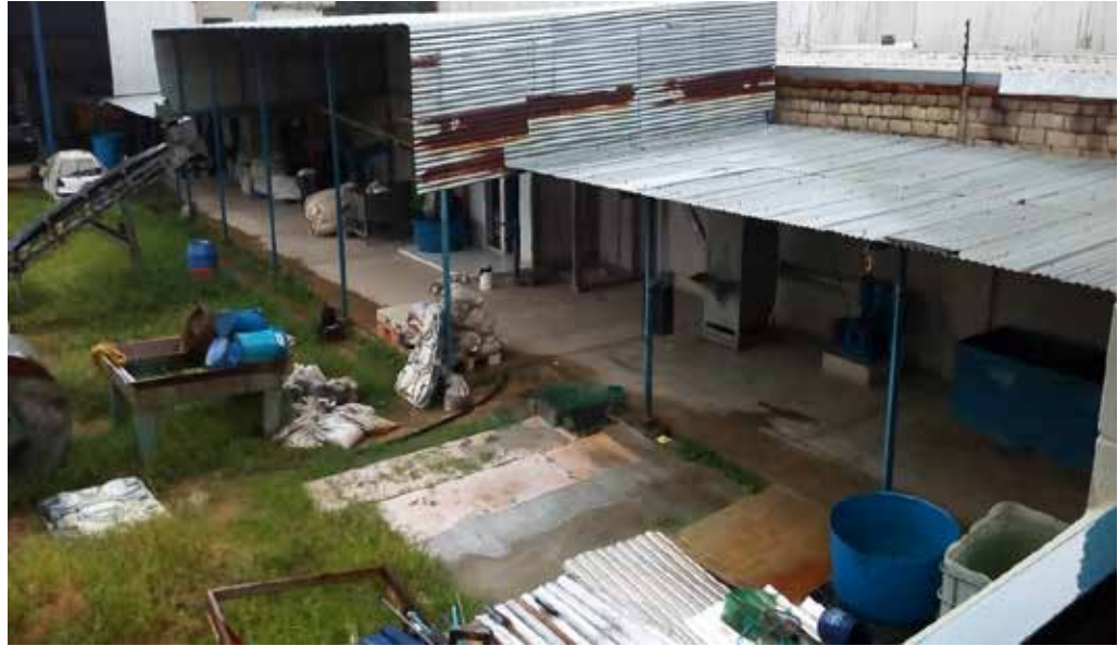
Figura 3. Planta instalada en la actualidad
