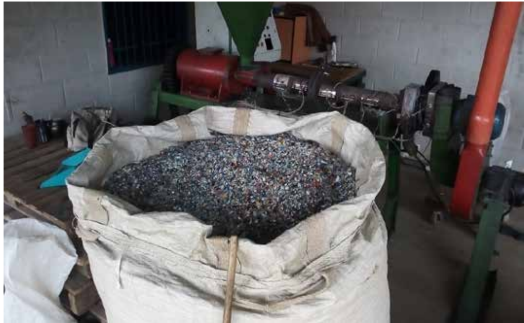
Figura 4. Espacios entre materia prima y equipos instalados operativos
