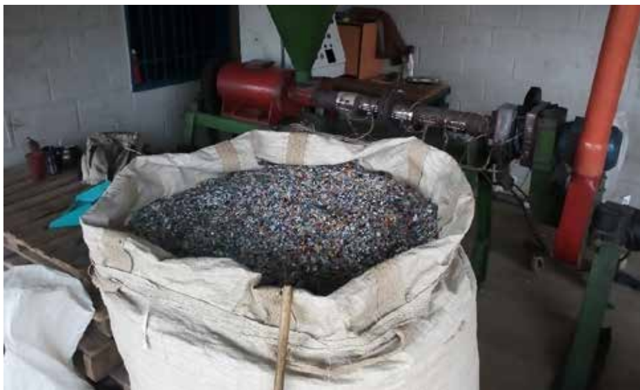
Figura 8. pelitezadora y material obstruyendo el paso y la producción.
