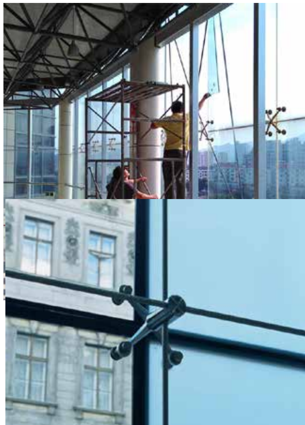
Figura 22. Instalación de Curtain Wall. Fuente: Guangzhou Sunnyquick Aluminium Manufacturing Co.,Ltd.. (2020)
