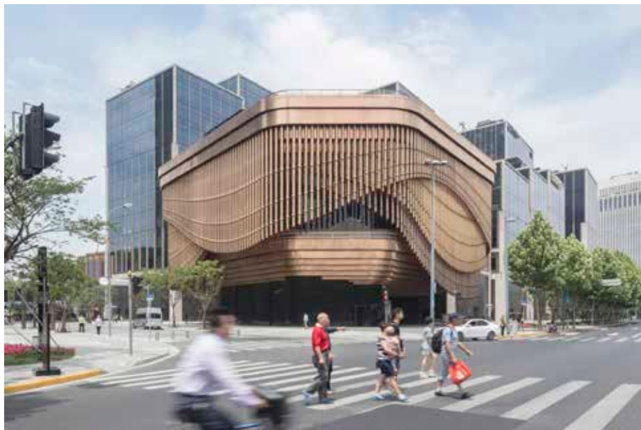
Figura 2. Fachada Centro Financiero Bund. Fuente: Plataforma Arquitectura (2017)
