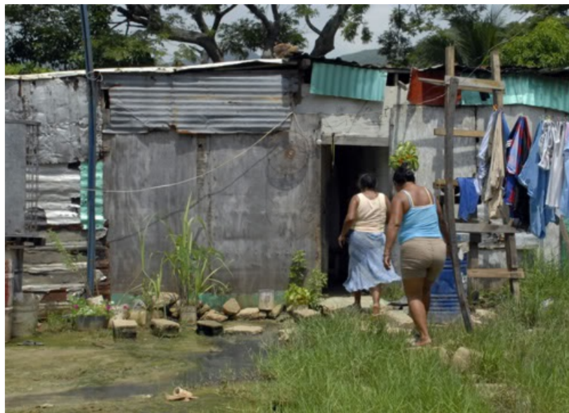
Figura 16. Viviendas precarias Av 81 Fuente. Ortega y Valente (2017)
