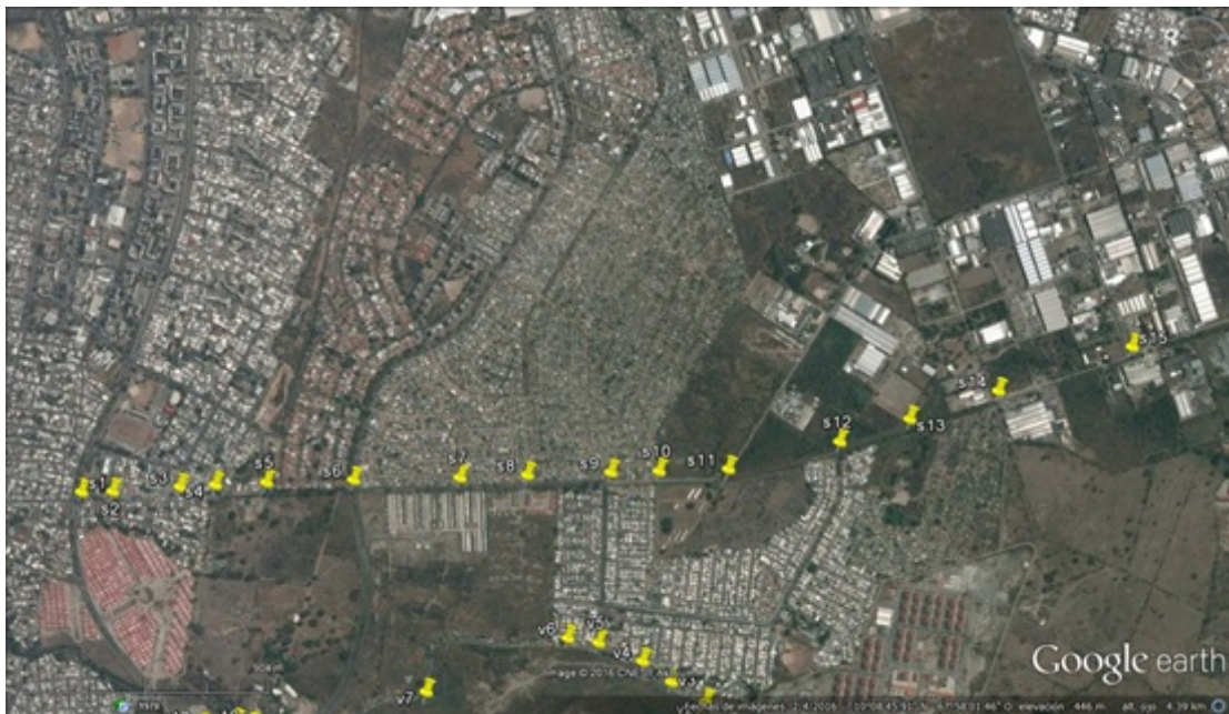
Figura 5. Vista aérea con señalización de la Avenida 81, tramo Avenida Sesquicentenario – Avenida Alameda Central del Municipio Valencia, estado Carabobo. Fuente: Google Earth (2017)
