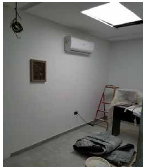
Figura 8. Vista del cuarto de comunicaciones donde se instalara servidor VPN.
