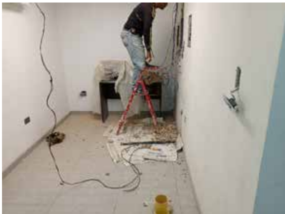
Figura 9. Personal instalando tablero eléctrico cuarto de comunicaciones.
