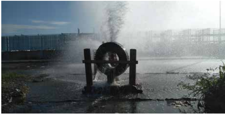
Figura 15: Fuga en tubería de distribución de agua potable
