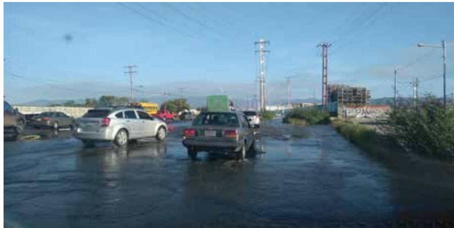
Figura 16: Deterioro vial como efecto de fuga en tubería del acueducto
