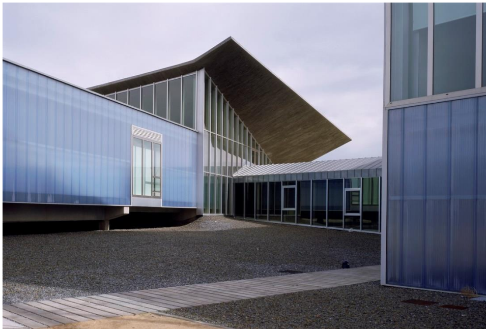
Figura 3: Vista de Laboratorios conectado con el Programa Docente. Fuente: https://www.plataformaarquitectura.cl/cl/02-149134/edificio-de-laboratorios-ciale-canvas-arquitectos/ (2007).
