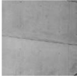
Figura 31: Concreto Armado Pulido (2018)
