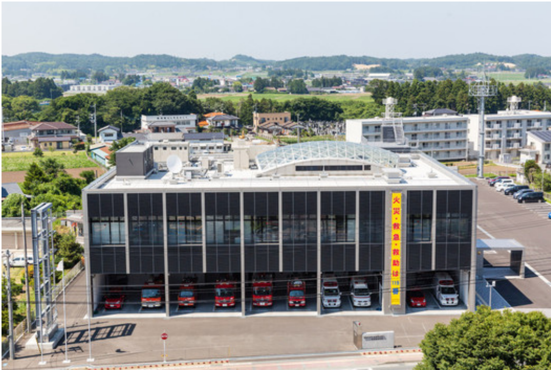
Figura 3: Galería, Estación de Bomberos, Minamisoma, Japón, 2015 Fuente: https://www.plataformaarquitectura.cl/cl
