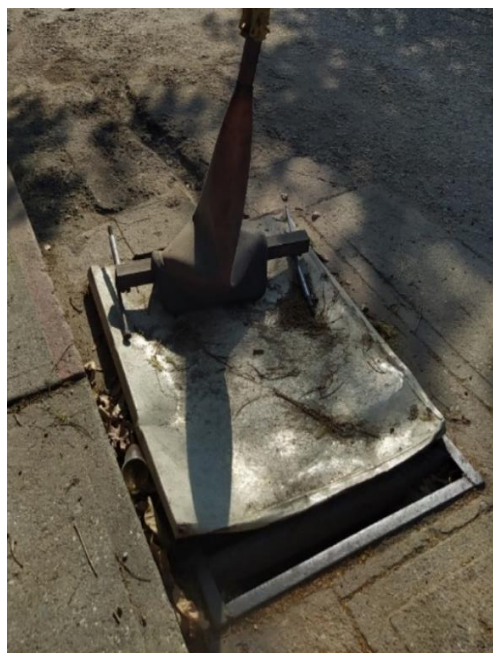
Grietas y alcantarilla sin rejilla, presente en el tramo I.
