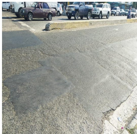
Baches y machas en el pavimento, presente en el tramo III.
