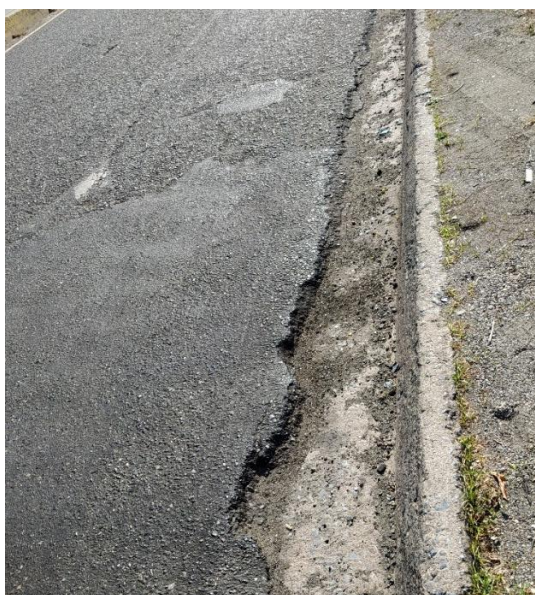
Grietas de borde y desnivel calzada – hombrillo, presente en el tramo III.
