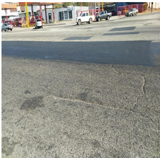
Baches y machas en el pavimento, presente en el tramo III.
