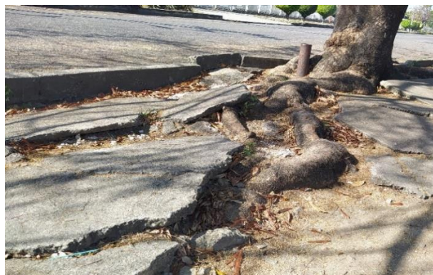
Figura 71: Aceras presentes en el tramo III.
