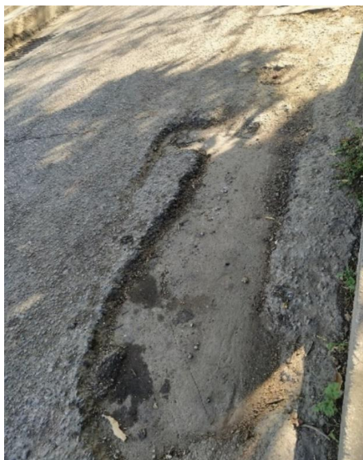
Hundimientos y huecos, presente en el tramo I.
