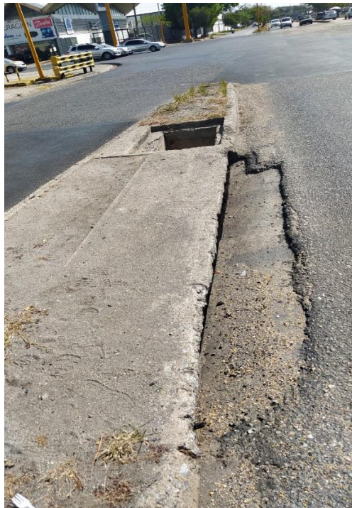
Sumidero lateral y sumideros de rejillas, presente en el tramo II.
