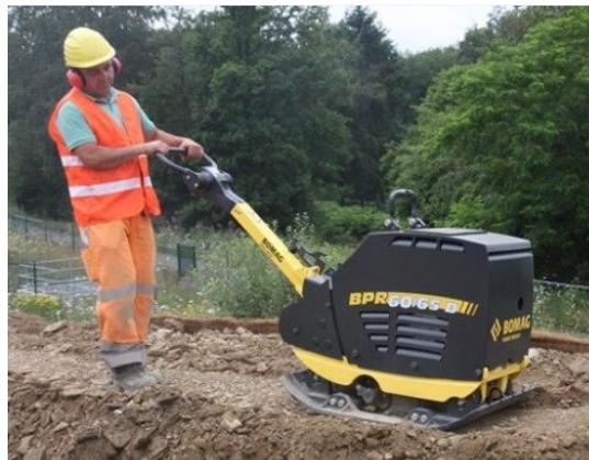
Figura 6: Bandeja de asfalto.
