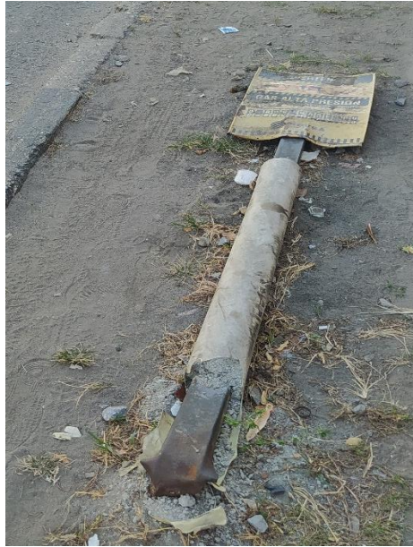
Figura 60: Señalización de tubería de gas presente en el tramo III.
