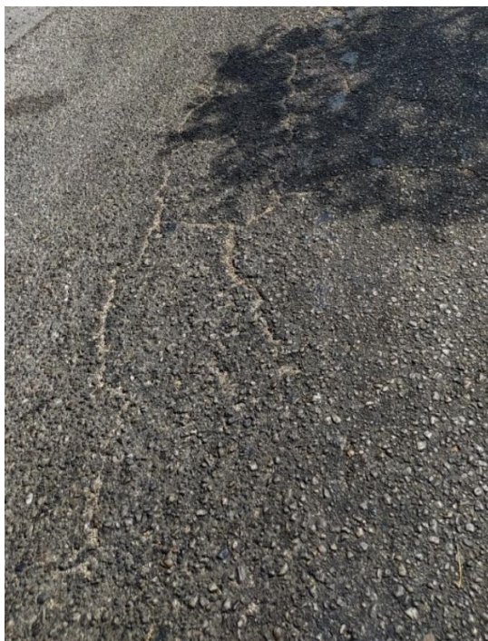
Falla desintegración y piel de cocodrilo, presente en el tramo II.
