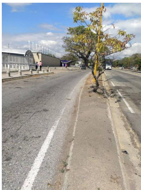
Figura 55: Demarcación en el pavimento del tramo II.
