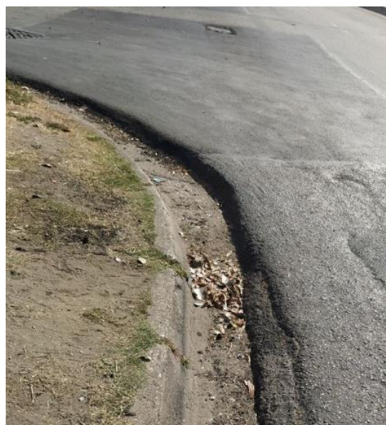
Grietas de borde y desnivel calzada – hombrillo, presente en el tramo III.
