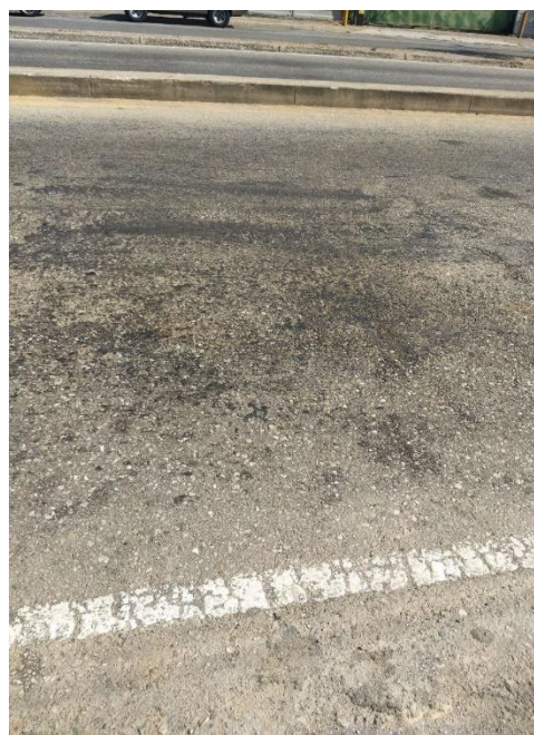
Grietas de reflexión de juntas y disgregación, presente en el tramo II.
