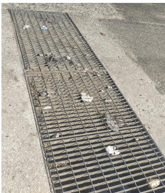
Figura 40: Sumidero de rejilla presente en el tramo I.
