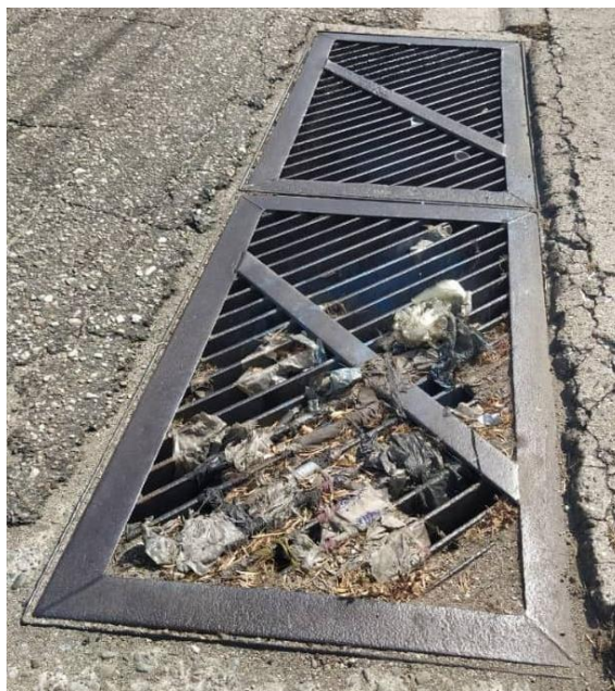
Figura 46: Sumidero de rejilla presente en el tramo II.
