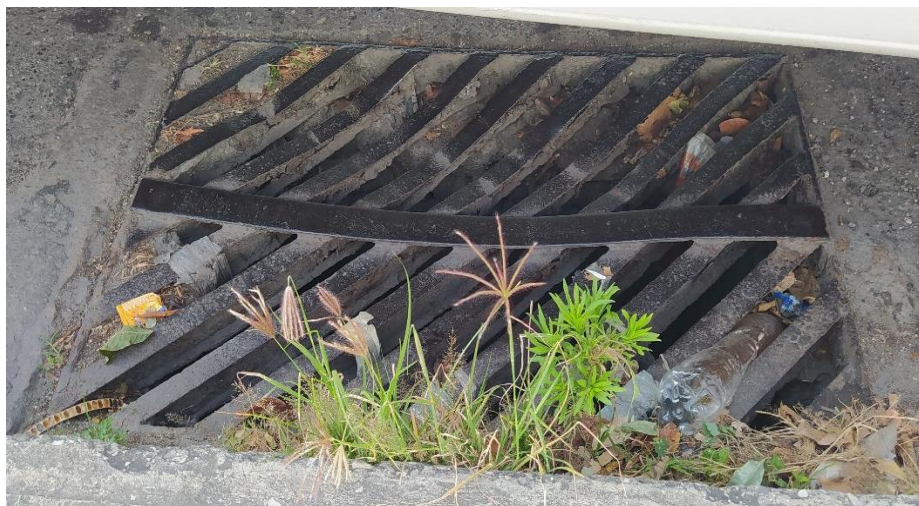
Figura 39: Sumidero de rejilla presente en el tramo I.
