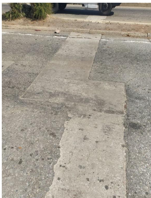
Grietas de reflexión de juntas y disgregación, presente en el tramo II.
