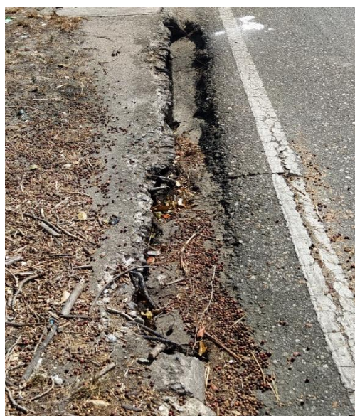
Figura 44: Sumidero lateral o de ventana presente en el tramo II.
