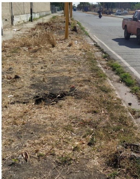
Figura 70: Aceras presentes en el tramo III.
