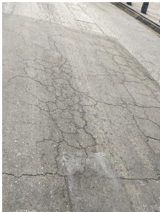
Falla desintegración y piel de cocodrilo, presente en el tramo II.
