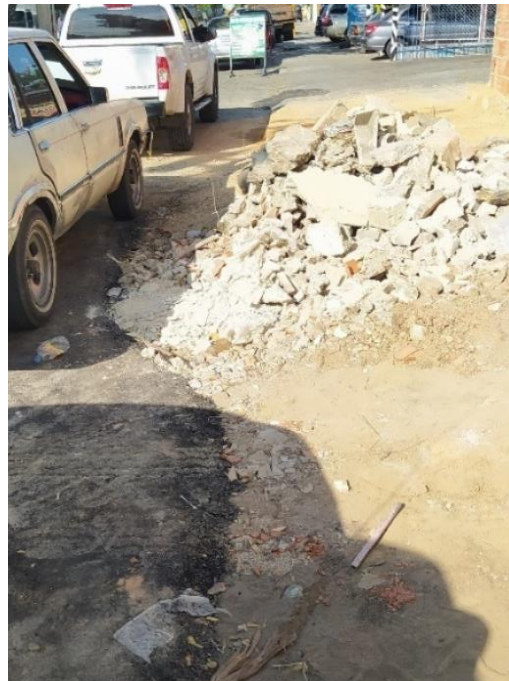
Figura 67: Aceras presentes en el tramo I.
