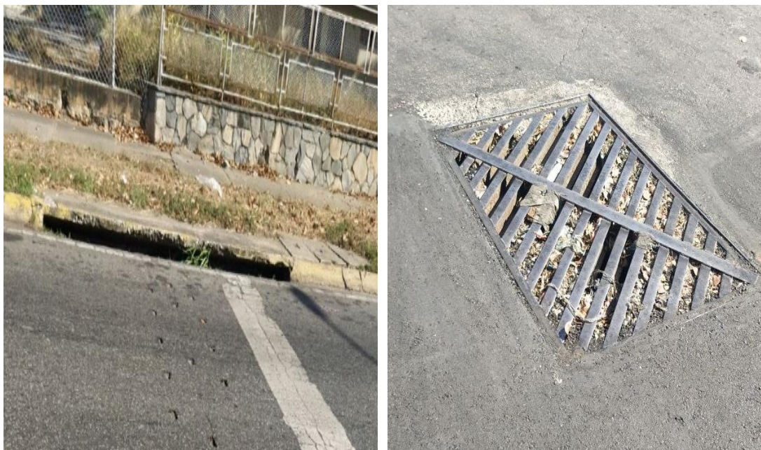
Sumidero lateral y sumideros de rejillas, presente en el tramo II.
