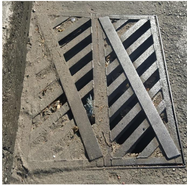
Figura 41: Sumidero de rejilla presente en el tramo I.
