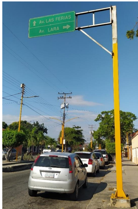
Figura 57: Señalización informativa del tramo I.
