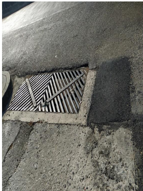
Falla desnivel por cruce de sumideros de rejillas, presente en el tramo I.
