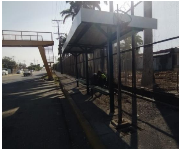
Figura 63: Parada de transporte en el tramo III.
