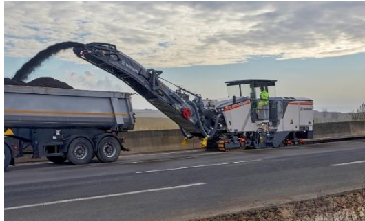
Figura 2: Fresadora de pavimento.
