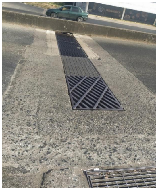
Falla desnivel por cruce de sumideros de rejillas, presente en el tramo I.
