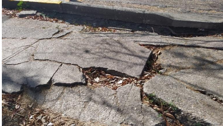
Figura 68: Aceras presentes en el tramo II.
