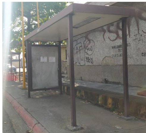
Figura 62: Parada de transporte en el tramo III.
