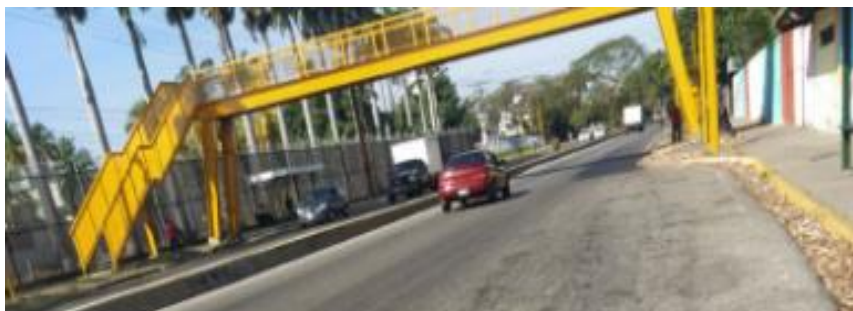
Figura 72: Pasarela peatonal en el tramo III.
