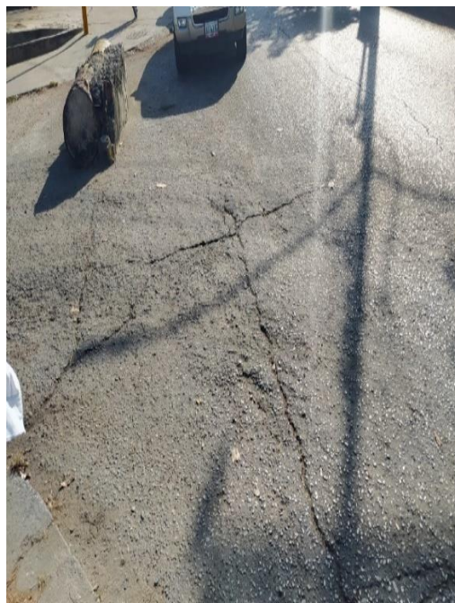
Piel de cocodrilo, disgregación y desintegración, presente en el tramo I.
