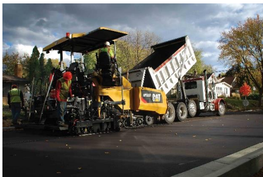
Figura 3: Extendedora de asfalto.
