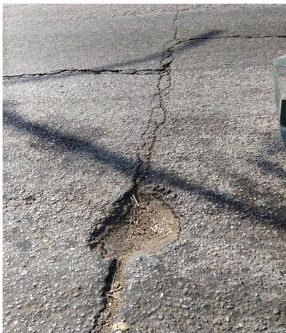
Grietas y alcantarilla sin rejilla, presente en el tramo I.
