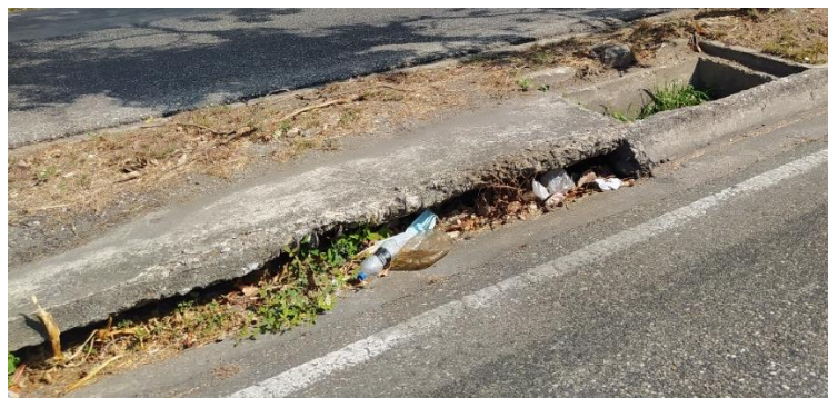
Figura 43: Sumidero lateral o de ventana presente en el tramo II.
