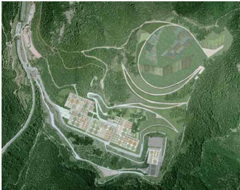
Figura 2: Vista aérea de implantación del CTRV. Fuente: https://bit.ly/2XSnXMC
