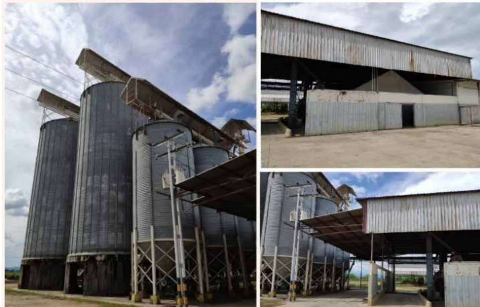
Figura 1: Vista frontal de las instalaciones.
