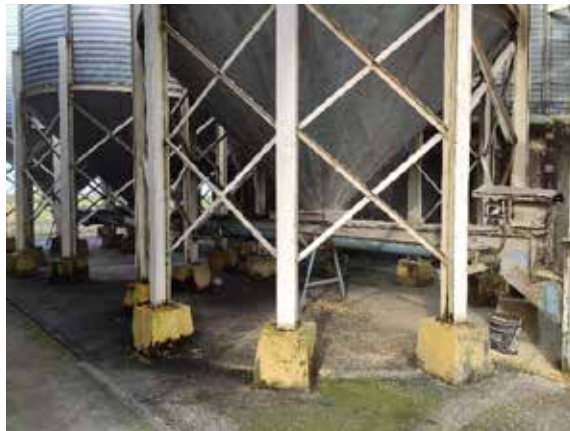
Figura 71: Descarga de silos a transportadores de sinfín.
