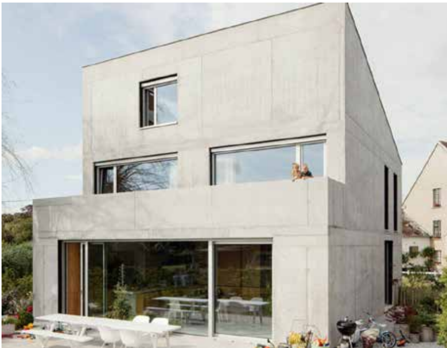
Acabado de Concreto obra Gris.
