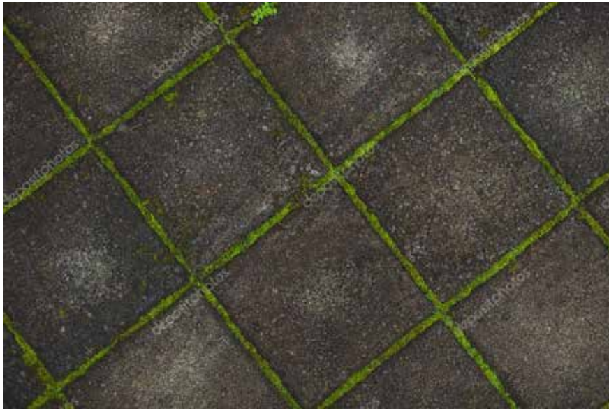
Acabado de piso exteriores – Adoquín Calado.
