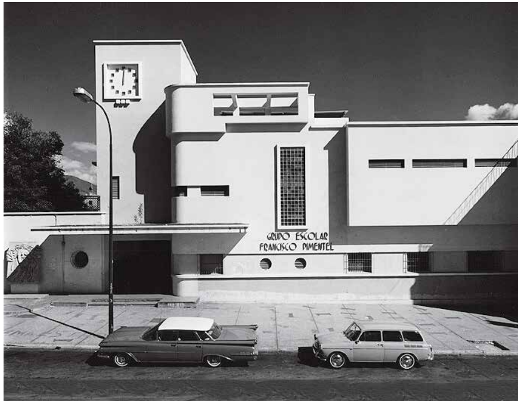
. Vista de Fachada Principal de la Escuela : http://guiacccs.com/obras/grupo-escolar-gran-colombia/
