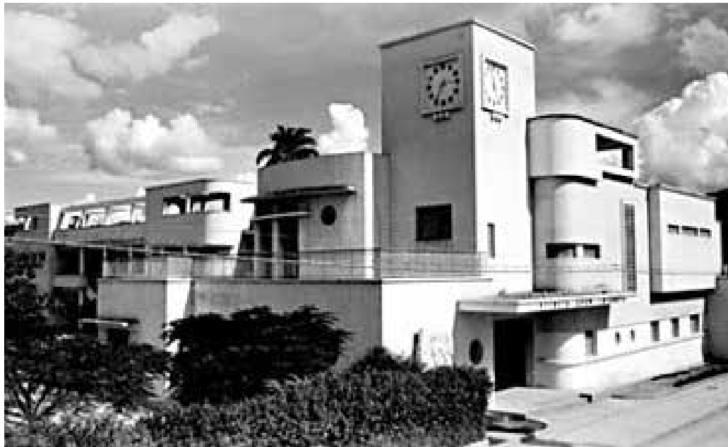
. Vista de Fachada Lateral Izquierda de la Escuela.
