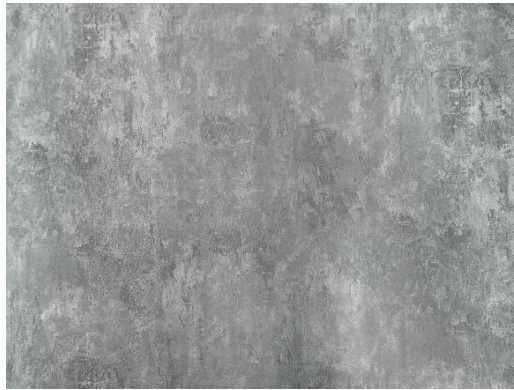
Figura 22. Piso de cemento requemado
