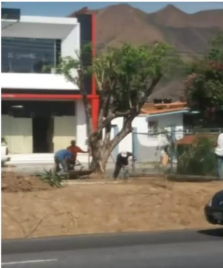
Figura 186: FOTO DE VIA DE SERVICIO MORRO II. TALA DE ARBOLES. Fuente: González y Pérez. (2023)
