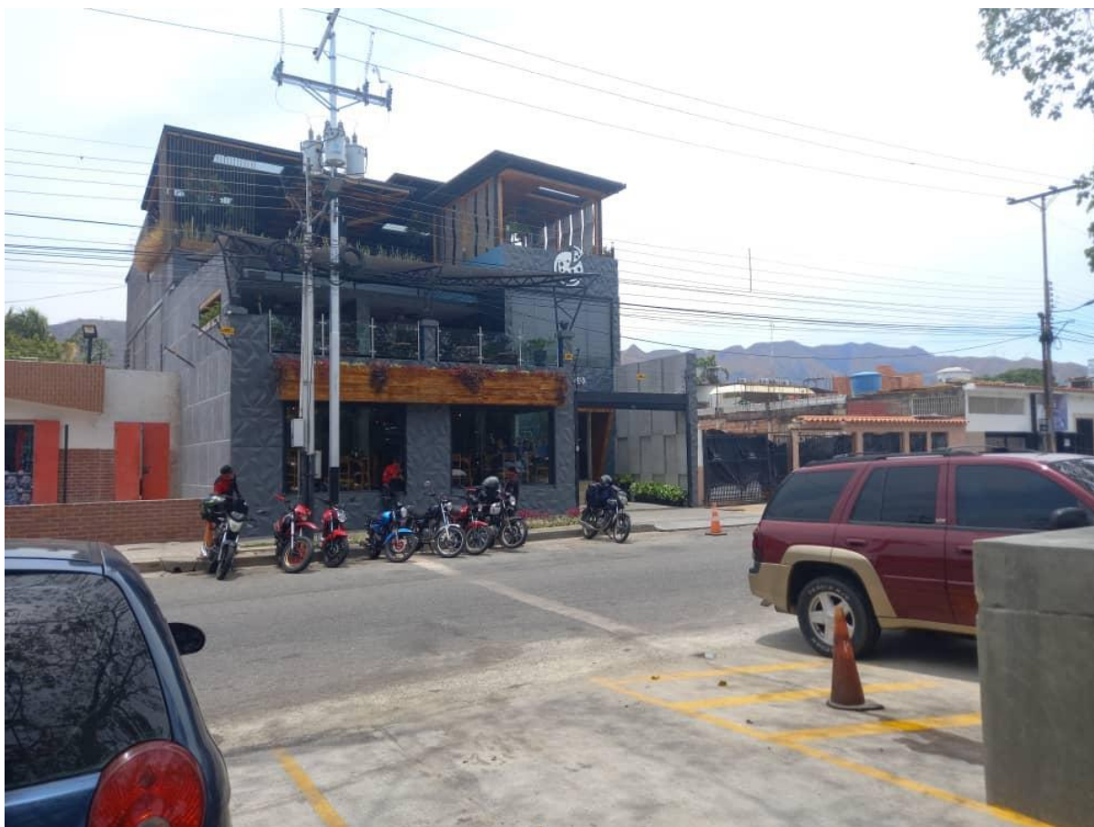
Figura 186: FOTO DE VIA DE SERVICIO MORRO II Fuente: González y Pérez. (2023)
