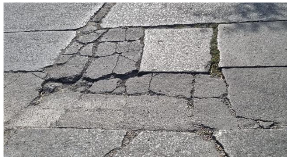
Figura 28: Hundimiento
