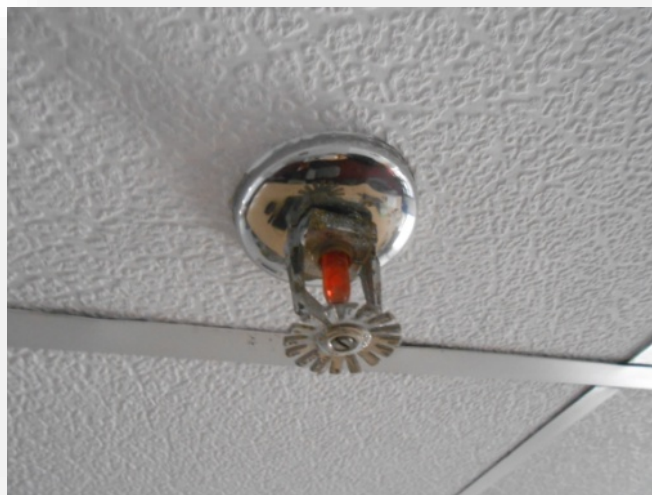
Figura 24. Rociador activado por ampolla Fuente: Elaboración propia
