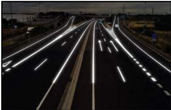
Imagen Nro.59. Calzada con pintura Fotoluminiscente
