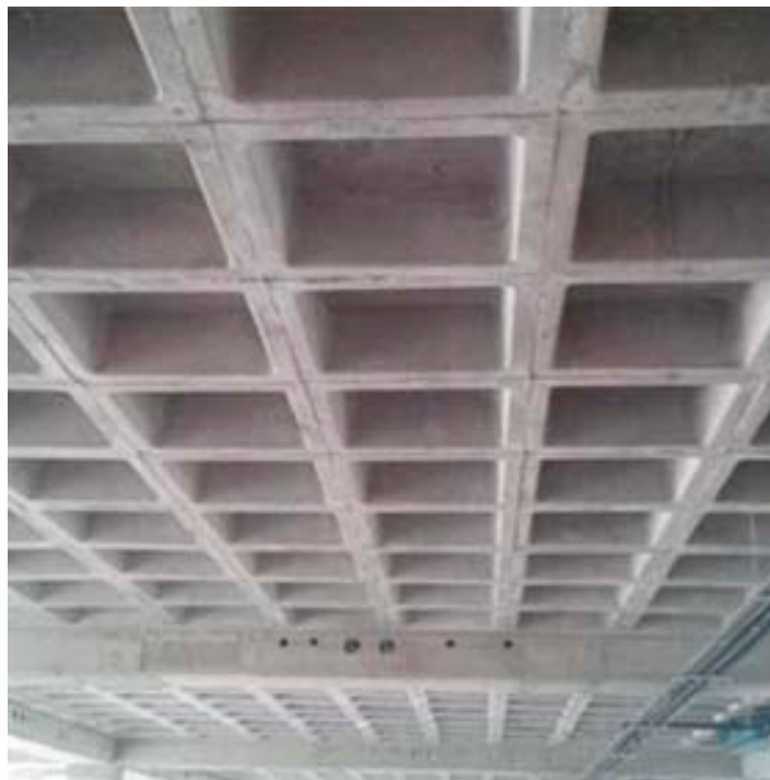
Figura 32. Losa Nervada construida.
