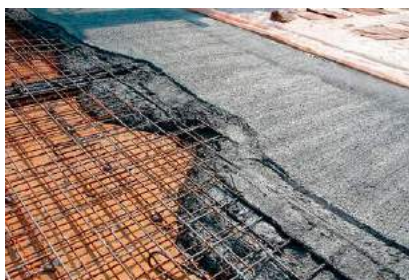
Gráfico 50: Losa de Concreto Armado Maciza.
