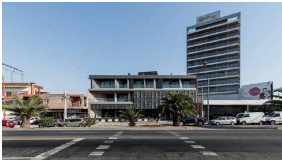
Figura 5. Fachada del hotel estilo mb.
