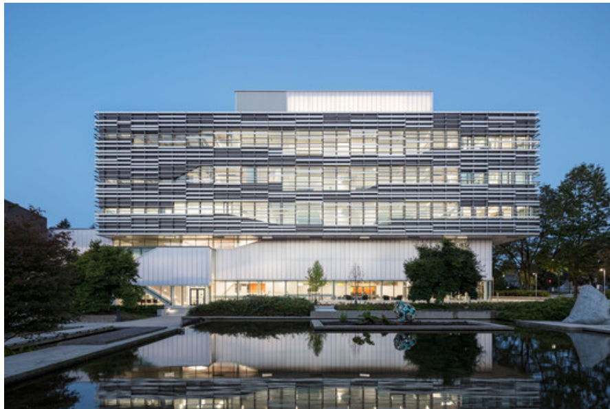
Figura 1 Edificio Langara de ciencia y tecnología. Fuente:
