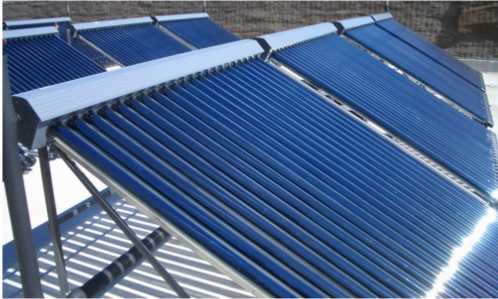
Figura 17. Colector de tipo tubular, empleado para el aprovechamiento de agua sanitaria.
