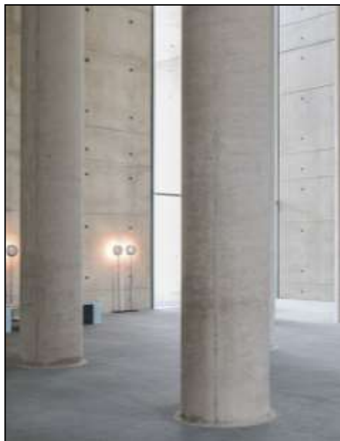
Figura 92. Columnas de concreto
