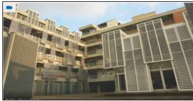
Figura 4 Escuela Municipal Carlos Soubllette y Ambulatorio Bello Campo Fuente; Arq. Ma+ Micucci + Arquitectos Asociados (2008)
