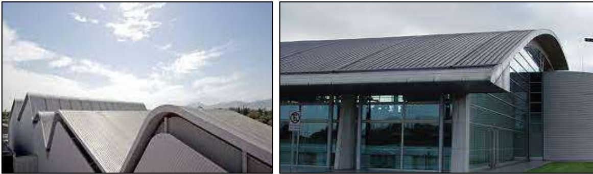
Figura 80. Revestimiento de losa de la cubierta.
