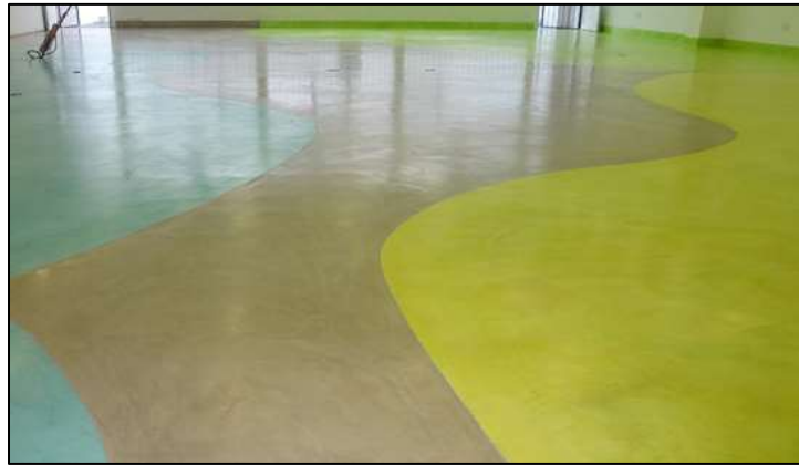
Figura 74 Acabado de piso interno planta alta
