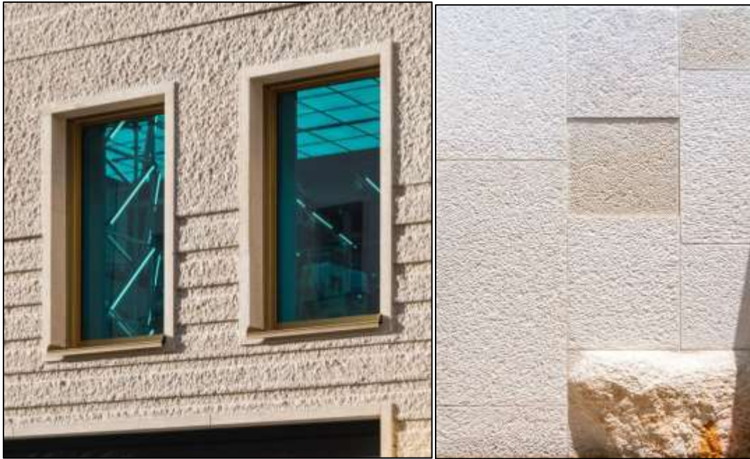
Figura 58. Acabado grafiado para las fachadas. Fuente: https://www.pinterest.es/pin/56998751524557549/
