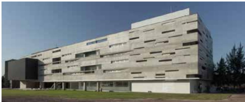
Figura 4. Vista frontal. Instituto de biotecnología Fuente: plataforma arquitectura (2011)
