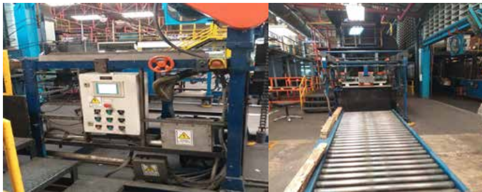
Figura 6. Final de la línea 3 de litografía y el panel de control del desmontador.
