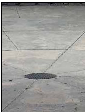
Figura 22. Alcantarillas. Fuente: Google Maps (2016)
