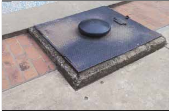
Figura 20. Tanquilla. Fuente: Google Maps (2016)
