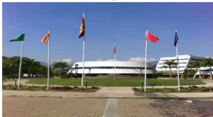
Figura 1 Villa Olímpica de Naguanagua
